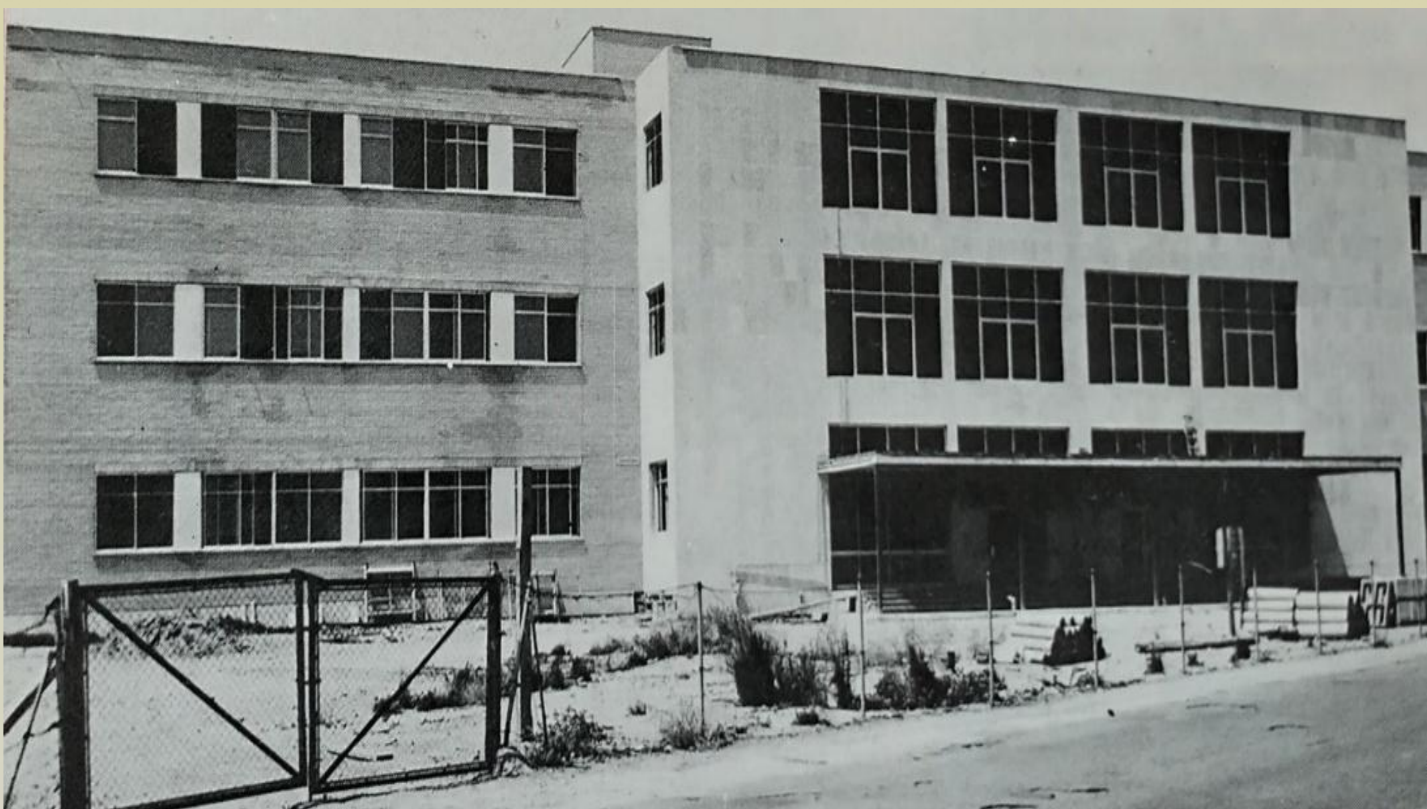
El Aulario en una fase avanzada de las obras a finales de 1980 o enero de 1981. Fuente: Universidad , 2ª época, nº 1 (enero de 1981), portada.
